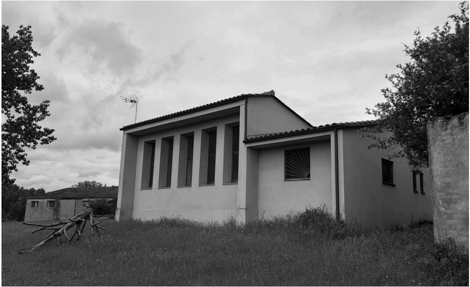
Trasera del edificio escolar
